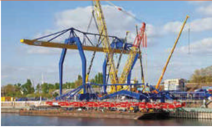
Die Anlieferung und Vormontage im April geschah über den Wasserweg
